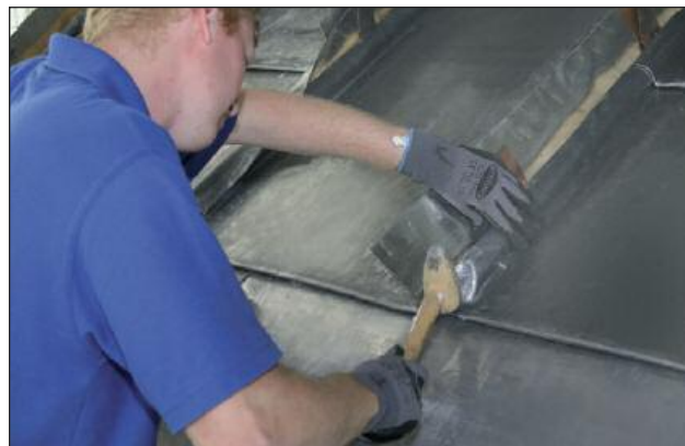
Bei großformatigen Bleiflächen zeigt die Falztechnik ihre Stärke: Die ausdehnungsfähigen Verbindungen lassen das Material arbeiten und gewährleisten stabile, sauber gegliederte Dachflächen über viele Jahre.
