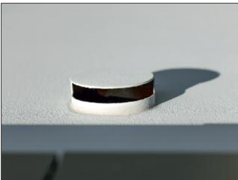
Damit die Entwässerung das Fassadenbild nicht stört, verlaufen die Fallleitungen hinter der Fassade. Nur für die Entlüftung der Rohre ist ein Durchbruch notwendig. Dies ist elegant mit einer „Wuppertaler Blende“ im Farbton des Fassadenputzes gelöst. Von unten ist die Blende geschlossen und fügt sich so harmonisch in die Fläche ein.
