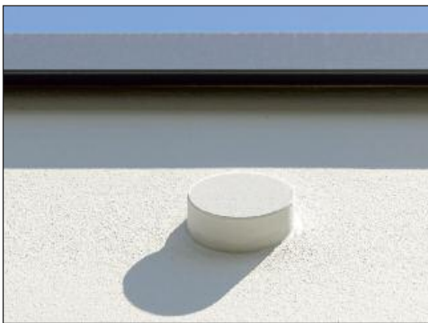
Damit die Entwässerung das Fassadenbild nicht stört, verlaufen die Fallleitungen hinter der Fassade. Nur für die Entlüftung der Rohre ist ein Durchbruch notwendig. Dies ist elegant mit einer „Wuppertaler Blende“ im Farbton des Fassadenputzes gelöst. Von unten ist die Blende geschlossen und fügt sich so harmonisch in die Fläche ein.
