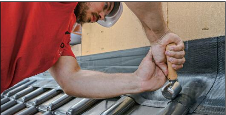
Ubbink ersetzt Bleianschlüsse am Steildach
