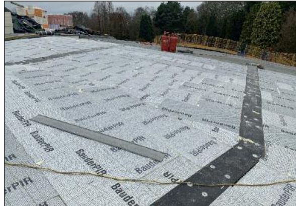
Verlegte Wärmedämmung aus BauderPIR.
