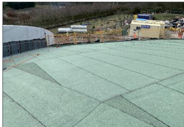
Zweite Abdichtungslage BauderPLANT E mit integriertem Durchwurzelungsschutz.
