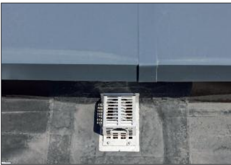
Auf dem nicht einsehbaren Flachdach geht es um (Abfluss-)Leistung. Durch die Wahl der Loro-Duo-fux-Attika-Direktabläufe genügen zwei Ablaufpunkte, um die gesamte Fläche sicher zu entwässern.
