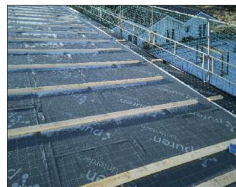
Über die notwendige Konterlattung werden die PU-Dämmstoffplatten mittels passender Systemschrauben im Untergrund fixiert. | Foto: puren
