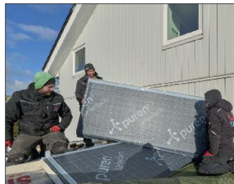
Aufgrund der Dachneigung von nur 9 Grad und der vorgesehenen Nutzung kam auf dem rund 200 Quadratmeter großen Satteldach über dem Anbau das puren Unterdach 023 zum Einsatz. | Foto: puren
